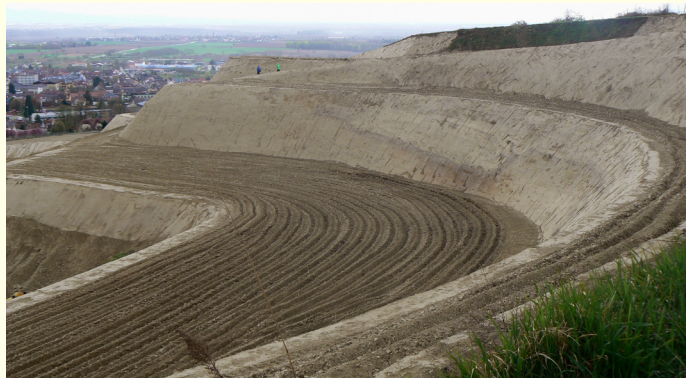
Abb. 4: Anlage von Großterrassen im Löss am Südrand des Kaiserstuhls, oberhalb der Gemeinde Ihringen
